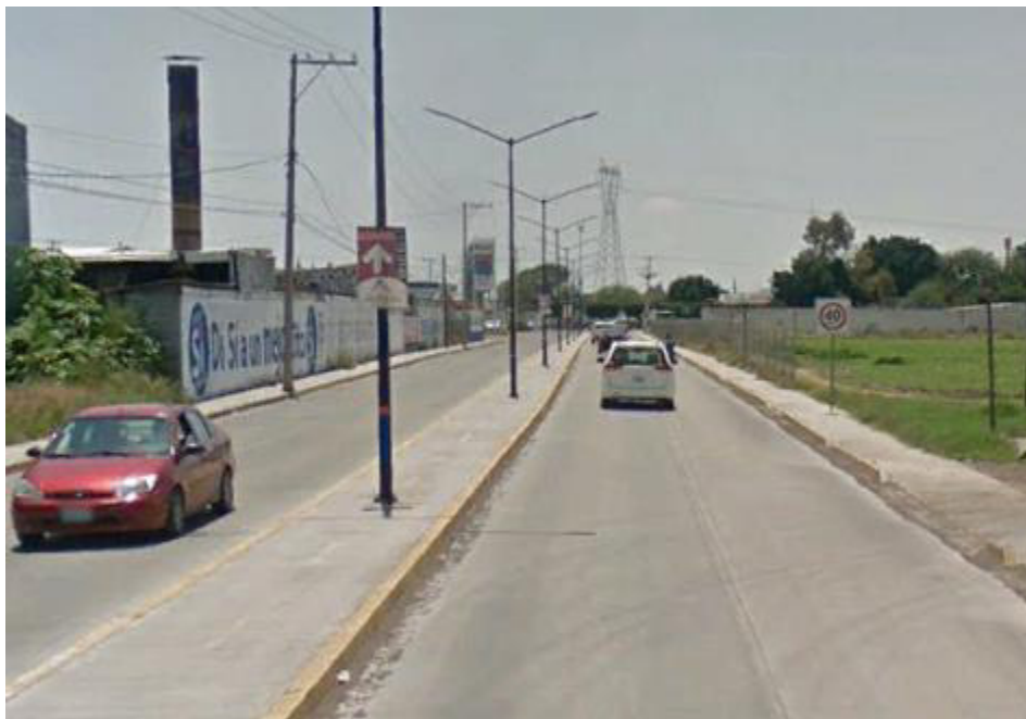
Vista del camino a manquera viendo de poniente a oriente
