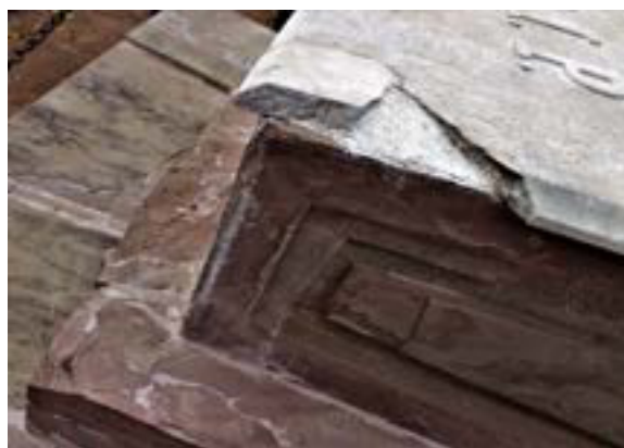
Imágenes 86 y 87. Fragmentación y deslaminación de la cantera, lado izquierdo y lado derecho.
