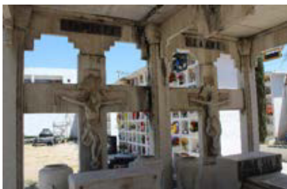
Imágenes 139 y 140. Invasión de costra negra y tinción en la parte superior.
