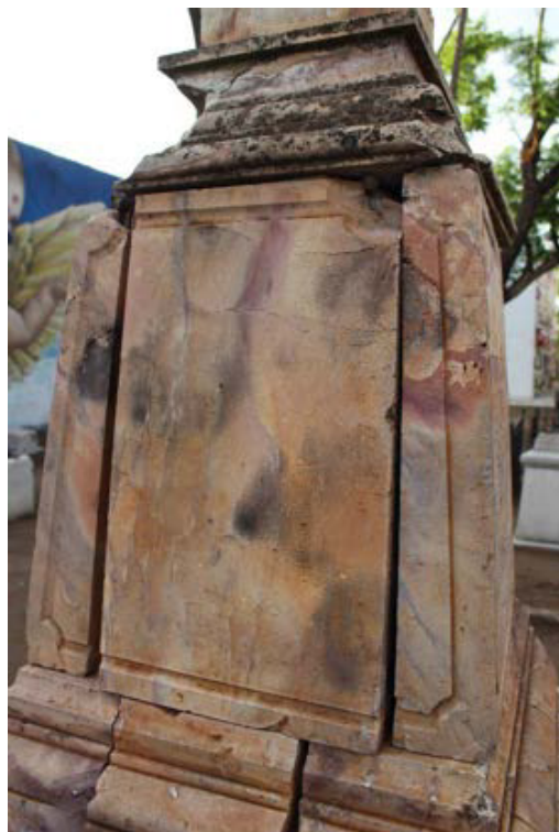
Imagen 84. Separación de los bloques de cantera.
