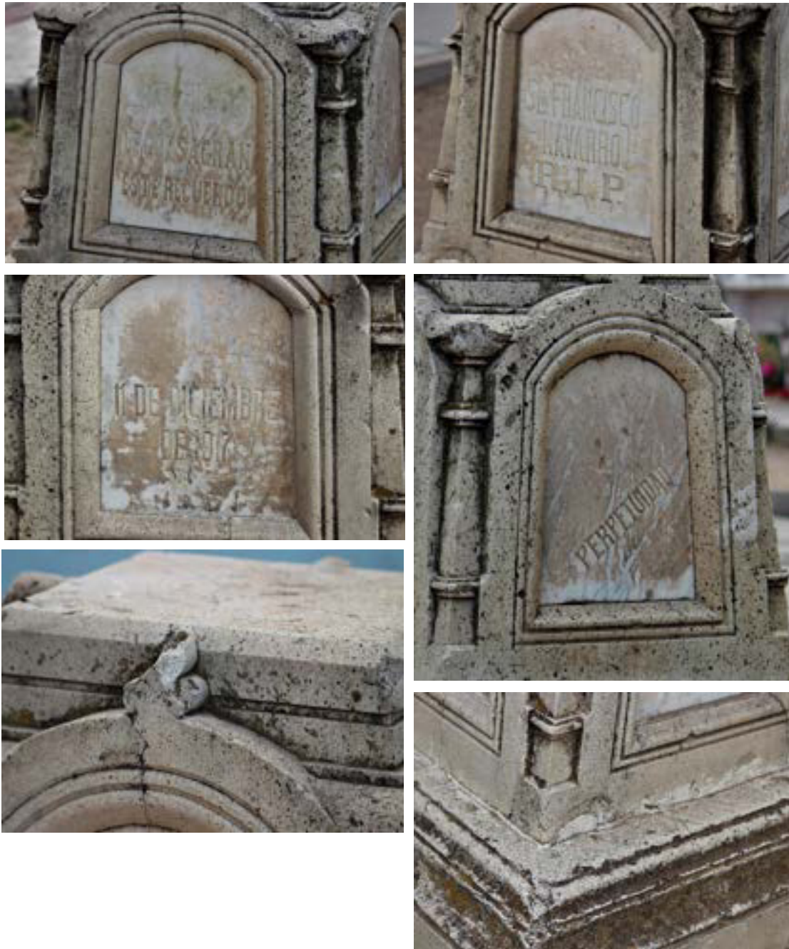
Imágenes 77, 78, 79, 80, 81 y 82. Muestra coloración las cuatro placas en mármol. Alveolización, invasión de musgo y costra negra.
