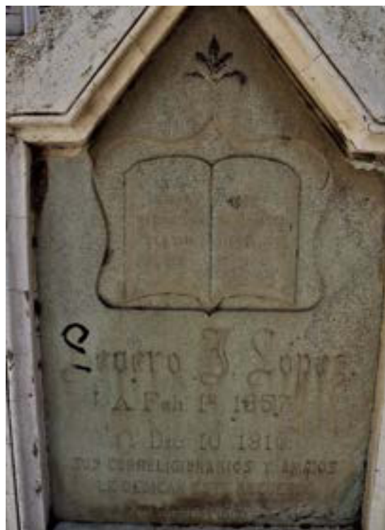
Imagen 52. Deslaminación de la cantera de la lápida.
