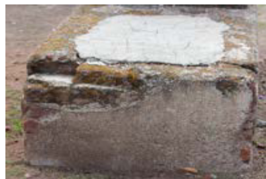
Imagen 40. Pérdida del recubrimiento y fragmentación.
