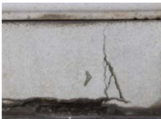
Imágenes 177. Fragmentación y fractura vinculadas en la base de la lápida.
