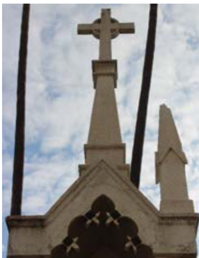
Imágenes 154, 155 y 156. El nicho presenta fisuras transversales. Pérdida de elemento. Fracturas en las esquinas.
