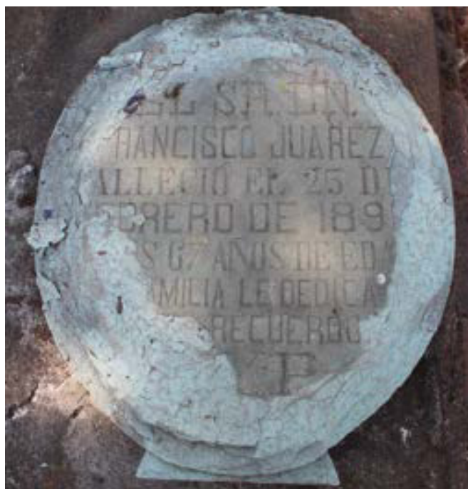
Imágenes 01 y 02. Esquina detrás de la tumba y deslaminación en la lápida.
