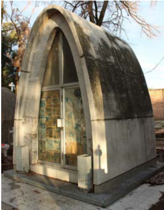
Imagen 222. Musgo en la cubierta.
