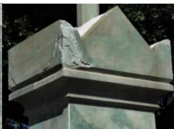
Imagen 54. Deslaminación en lado izquierdo del frontón del cipo.
