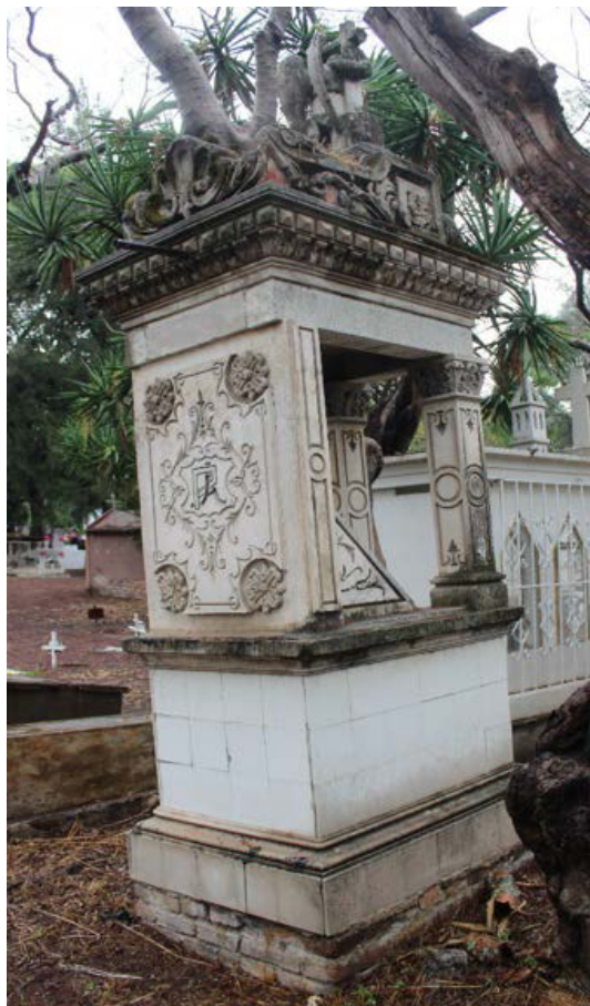
Imagen 52. Hundimiento a la derecha.
