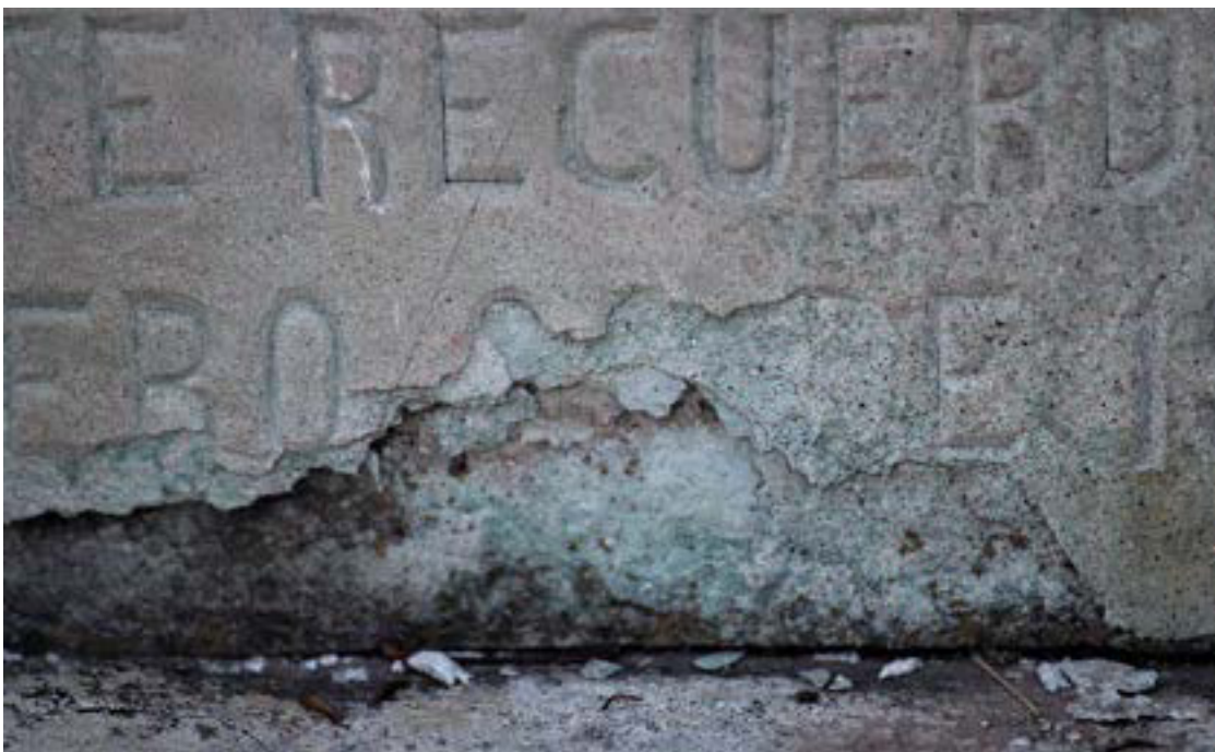
Imágenes 120 y 121. Fracturas en la parte superior y fragmentaciones en esquinas de la base del cipo.
