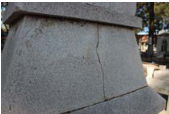
Imagen 139. Fisura transversal parte detrás de la cabecera.
