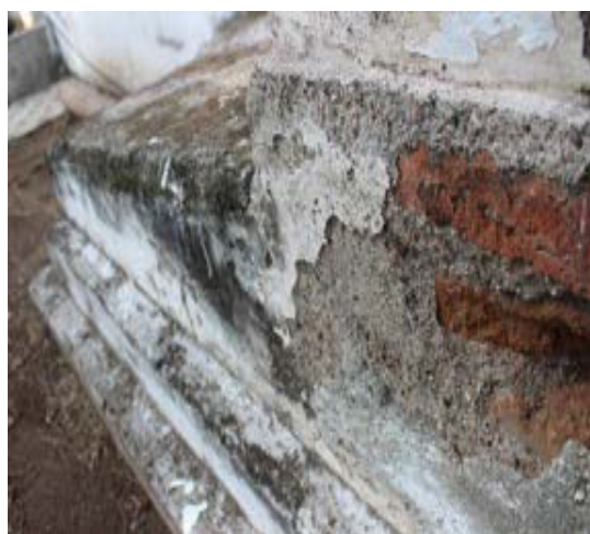
Imagen 58. Perdida de recubrimiento e invasión de musgo.
