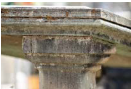
Imagen 146. Fisuras transversales, musgo y líquen.
