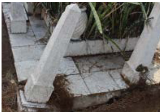
Imagen 188. Hundimiento de la tierra, lo que ocasiona la fractura y caída de piso.
