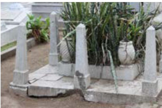
Imagen 187. Crecimiento en demasía de las plantas del sardinel. Fractura del jarrón de la derecha.
