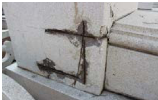
Imagen 158. Desconchaduras lado izquierdo de la cabecera.
