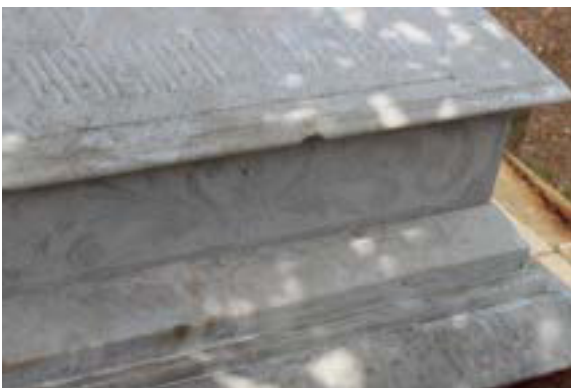
Imágenes 128 y 129. Tinción y enmugrecimiento en el mármol debajo de la pintura blanca.
