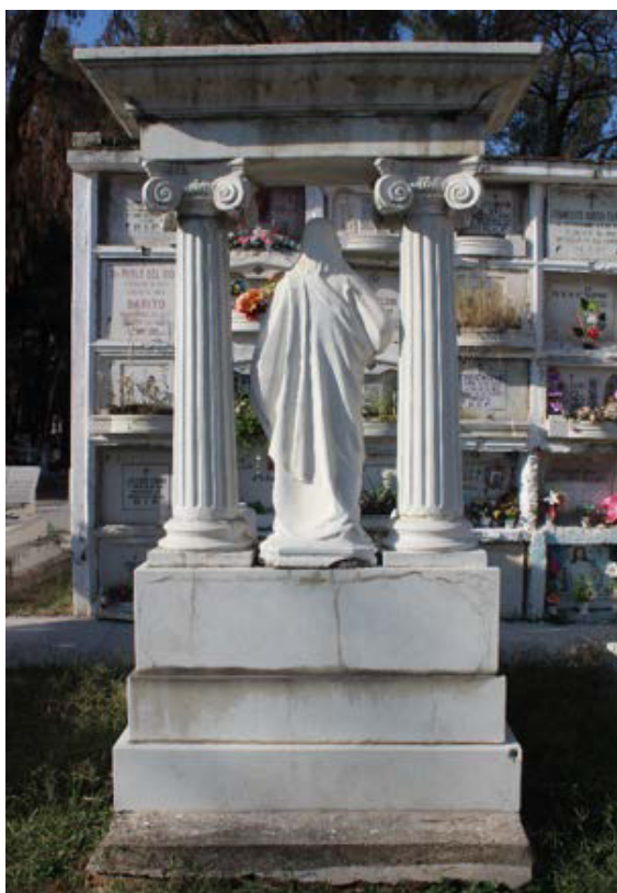
Imagen 175. Fisuras vinculadas en la cabecera y enmugrecimiento.
