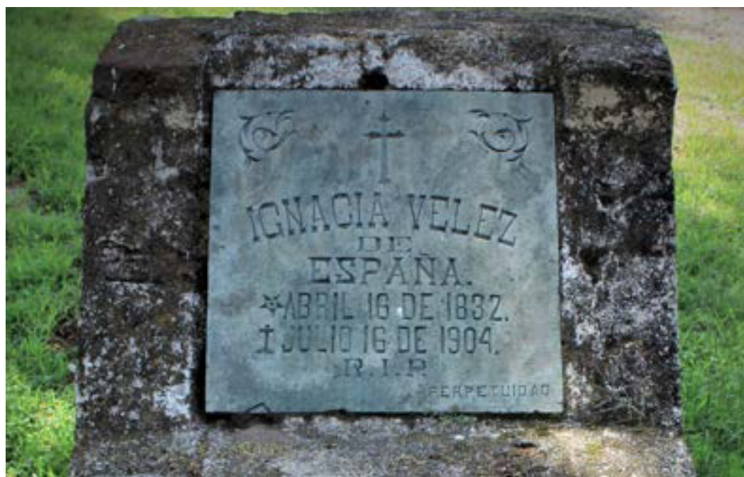
Imagen 22. Descamación de la cantera de la lápida.
