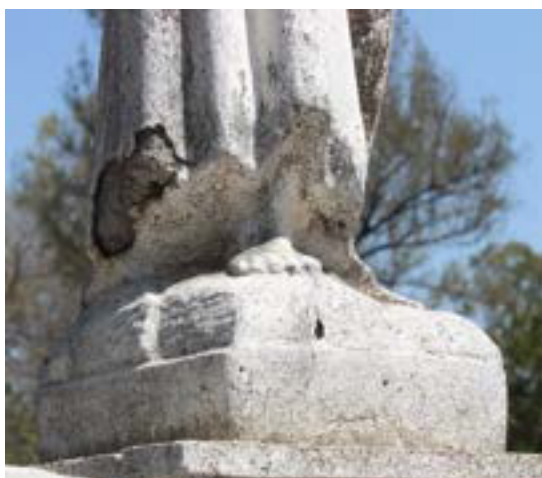
Imagen 79. Fragmentaciones, fracturas transversales y enmugrecimiento. Imagen 80. Facturas en la escultura central. Imagen 81. Fisuras transversales.
