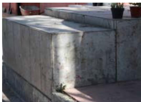
Imagen 163. Fragmentación en la parte superior de los bloques.
