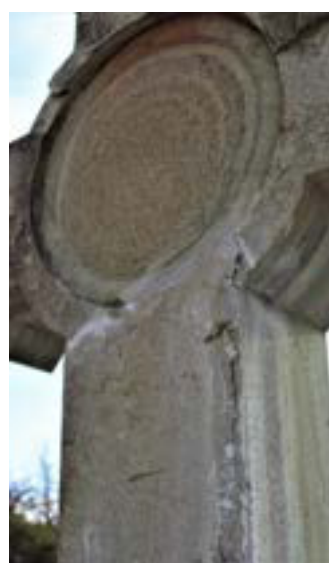
Imagen 77. Parte detrás descamación.
