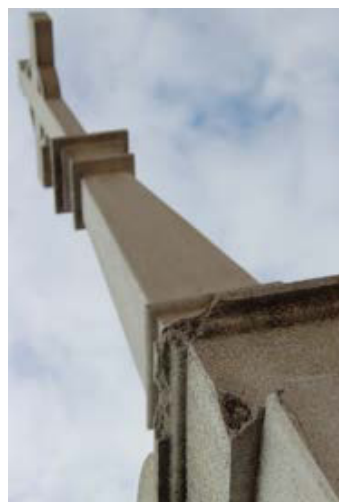
Imágenes 154, 155 y 156. El nicho presenta fisuras transversales. Pérdida de elemento. Fracturas en las esquinas.
