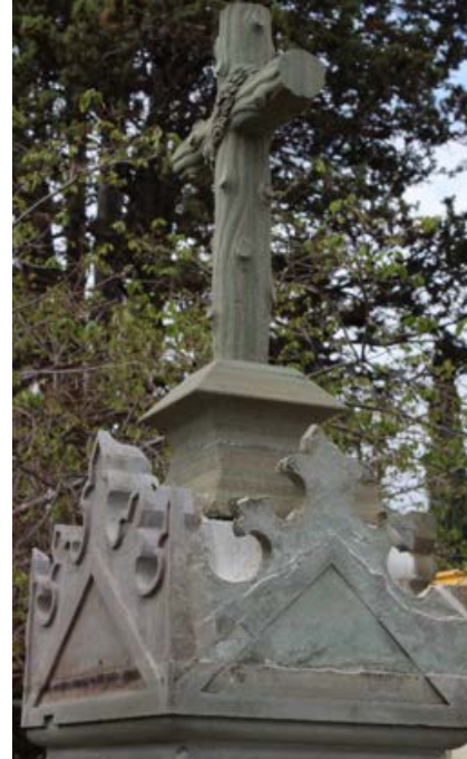
Imagen 40. Descamación y fracturas en los frontones.
