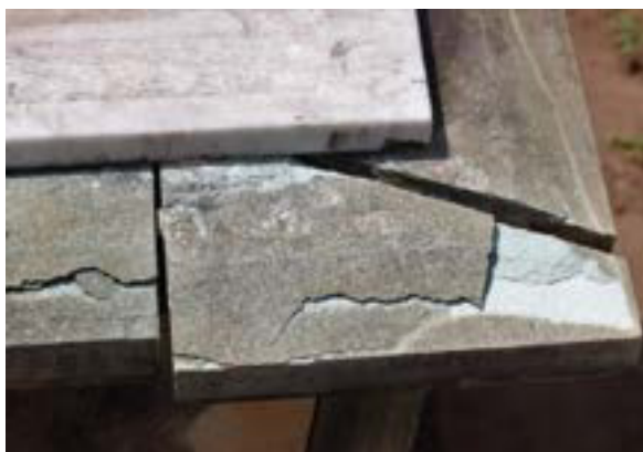
Imágenes 132 y 133. Movimiento en los bloques en cantera alrededor de la lápida. Fisuras transversales. Musgo y liquen.
