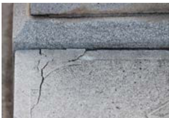
Imagen 90. Fisuras vinculadas en la lápida.
