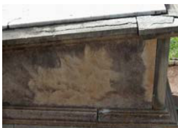
Imágenes 132 y 133. Movimiento en los bloques en cantera alrededor de la lápida. Fisuras transversales. Musgo y liquen.
