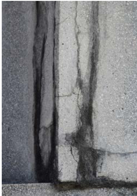
Imagen 157. Fisuras vinculadas y humedad.
