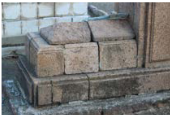
Imagen 118. Separación de las juntas en los bloques de cantera.
