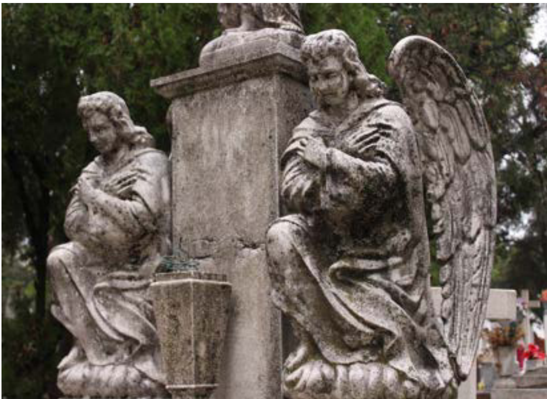
Imagen 77. Pérdida de la información del inhumado y del epitafio. Imagen 78. Invasión de costra negra y fisuras transversales.
