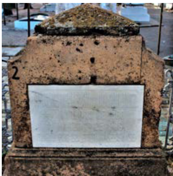
Imagen 44. Fisura transversal en la lápida en mármol.
