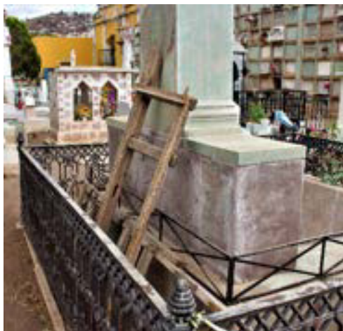
Imágenes 51 y 52. Actos de incuria, el caso de recargar una escalera sobre la inscripción con descamación, deslaminación y fractura.
