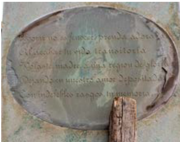
Imágenes 51 y 52. Actos de incuria, el caso de recargar una escalera sobre la inscripción con descamación, deslaminación y fractura.
