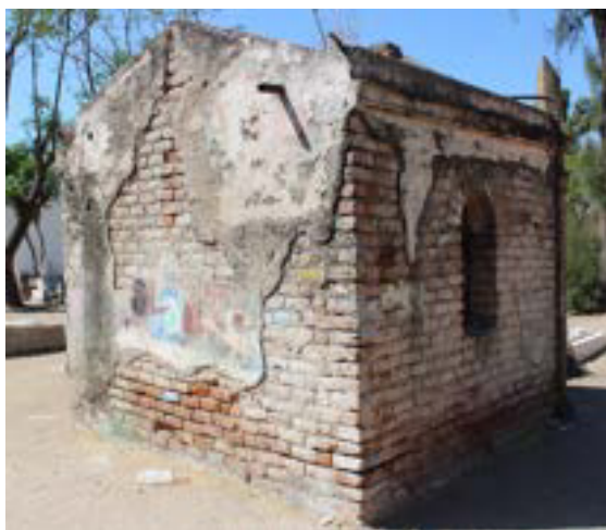
Imágenes 50 y 51. Pérdida del recubrimiento del tabique y hierbas en los muros exteriores.
