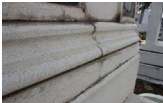
Imagen 159. Eflorescencia y fractura transversal.
