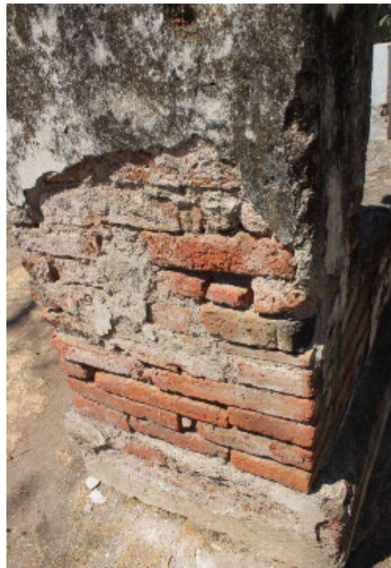
Imagen 68. Perdida del recubrimiento.
