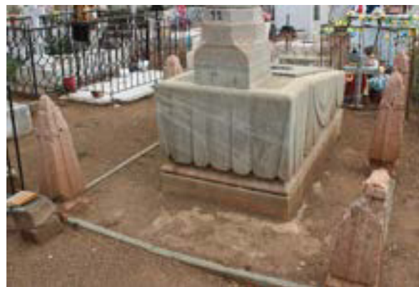
Imagen 119. Fracturas en los postes en cantera.
