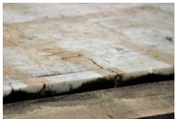
Imágenes 135. Costra negra y diversas fisuras individuales en la lápida.
