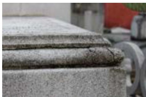
Imagen 125. Fractura, fisura individual y enmugrecimiento.
