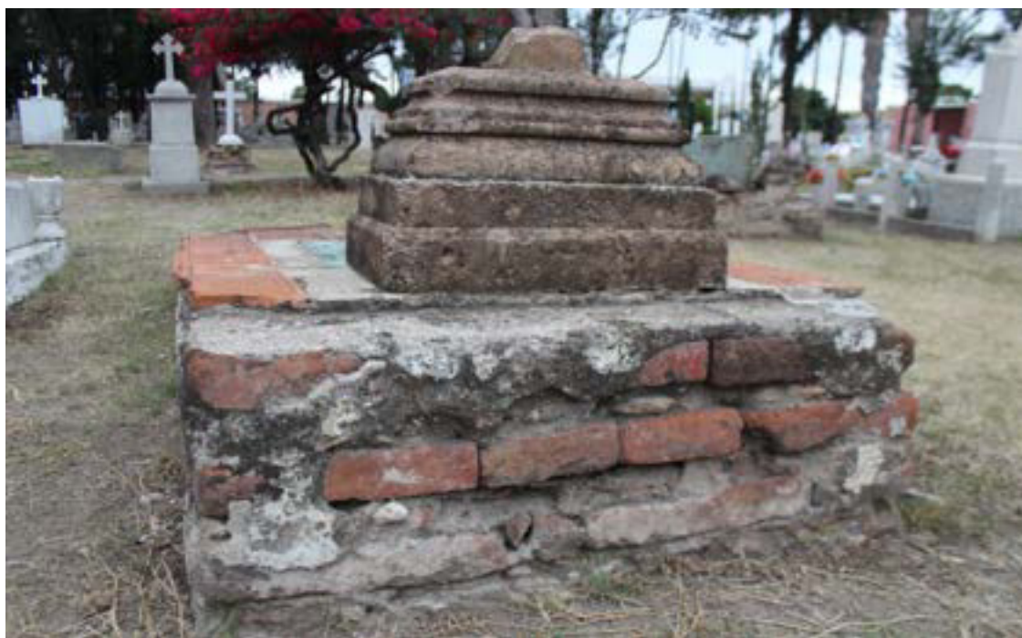
Imagen 19. Deslaminación en la cantera de la lápida.
