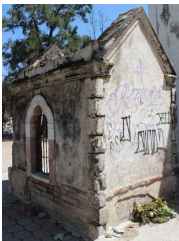
Imagen 74. Cubierta en mortero, invasión de musgo y deslaminación.
