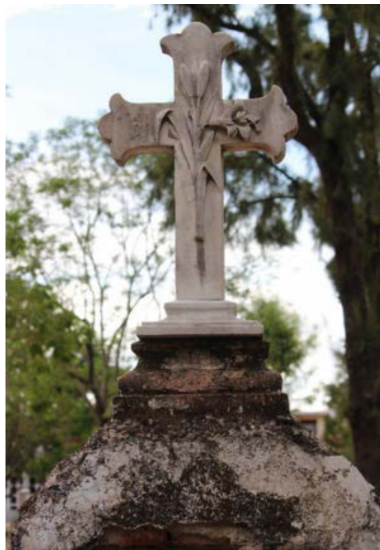
Imagen 67. Enmugrecimiento en la cruz, y degradación del nicho.
