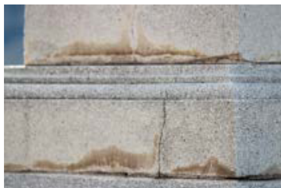
Imagen 89. Eflorescencia parte detrás y fisura transversal.
