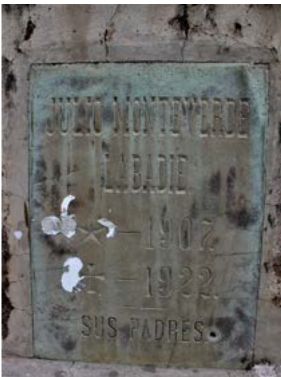
Imagen 79. La lapida en cantera con fisuras transversales, faltante en seguida de la palabra "padres", coloración, y manchas de pintura blanca.
