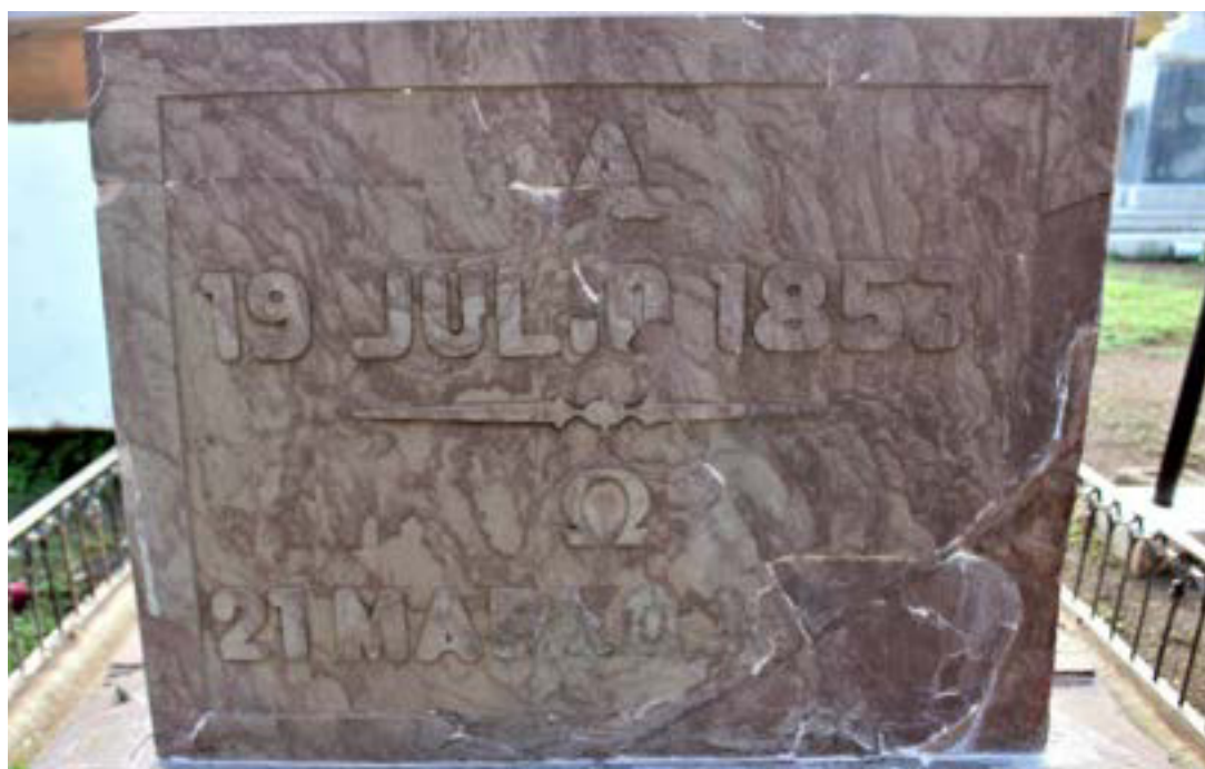
Imágenes 59 y 60. Lápida de frente perdida de letras de metal y lápida detrás deslaminación de la cantera.
