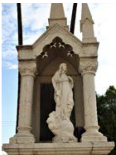
Imágenes 154, 155 y 156. El nicho presenta fisuras transversales. Pérdida de elemento. Fracturas en las esquinas.
