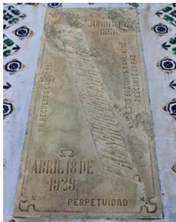
Imagen 149. Alveolización en la parte superior y media de la lápida.
