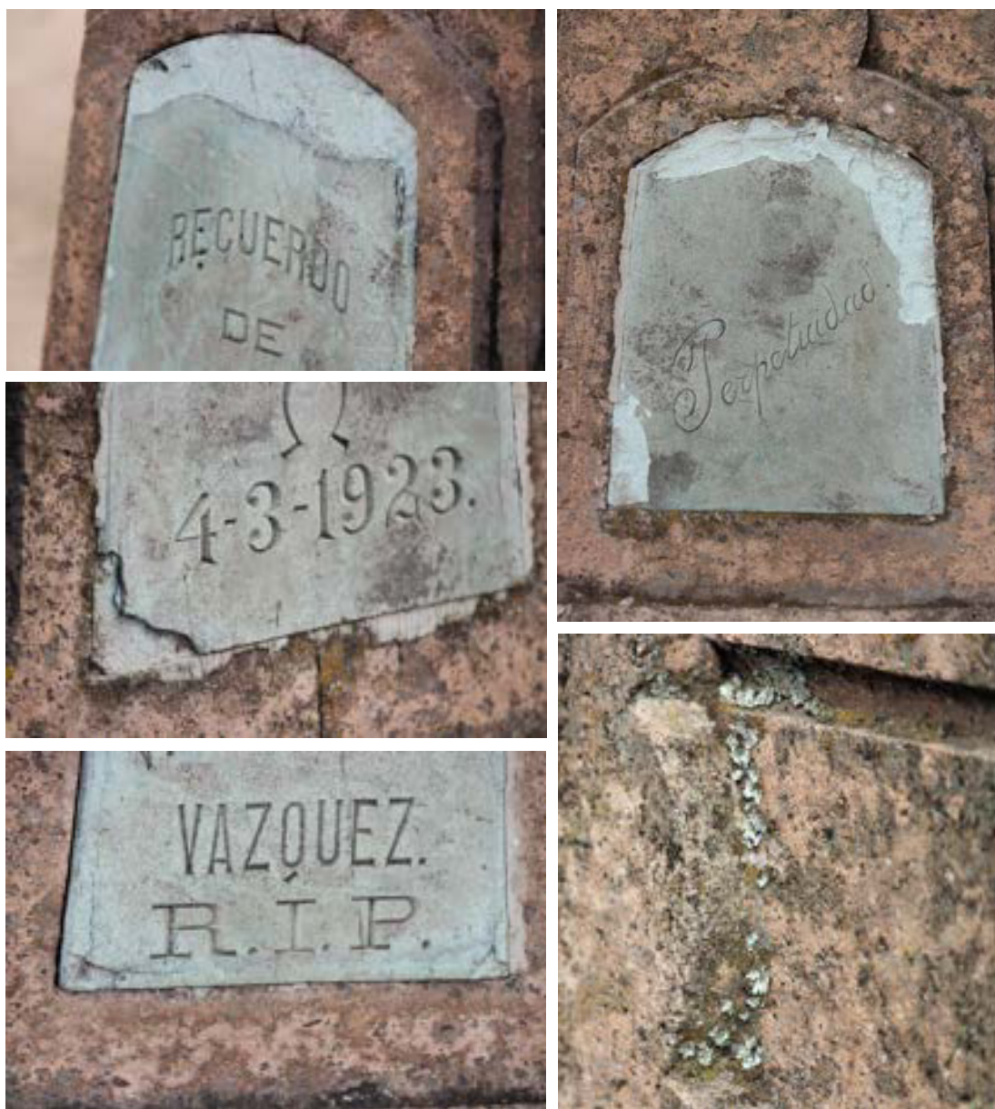
Imágenes 88, 89, 90, 91 y 92. Las cuatro caras del cipo con placas en cantera verde, con fisuras individuales y deslaminación. Invasión de musgo y liquen en varias áreas del monumento.
