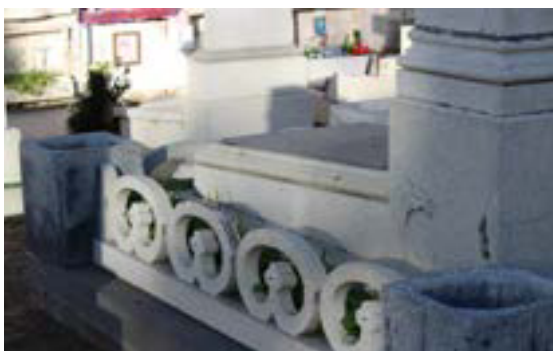
Imagen 157. Fisuras y desconchaduras lado derecho.
