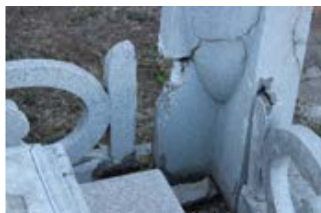
Imagen 128. Fragmentación por ambos lados de la valla.
