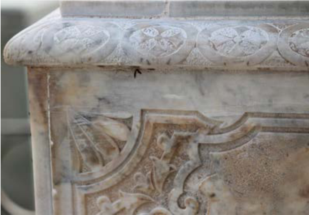
Imagen 34. Pintura a la cal sobre el mármol. Ubicación en la ficha técnica número 17, en el catálogo del Panteón de Santa Paula. (Fotografía por Gonzalo Marín).
