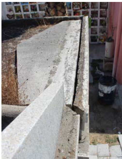
Imágenes 145 y 146. Hierba y elemento desprendido en el techo.
