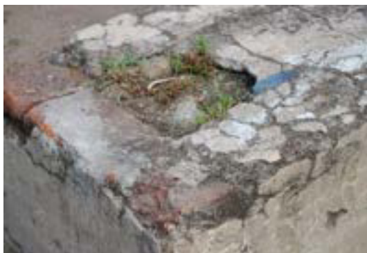
Imagen 77. Hueco en la parte superior del sepulcro.
