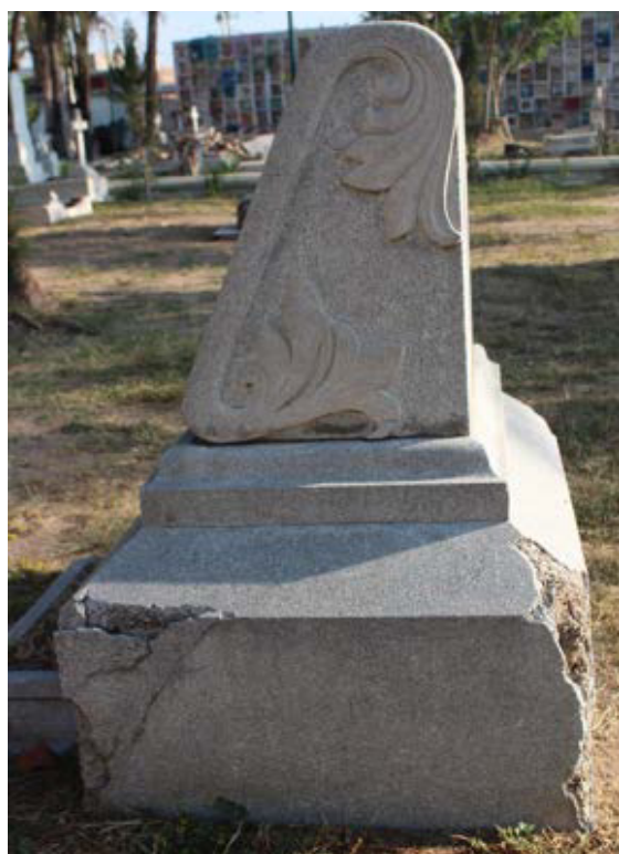
Imágenes 113, 114 y 115. Fracturas en la parte superior y fragmentaciones en esquinas de la base del cipo.
