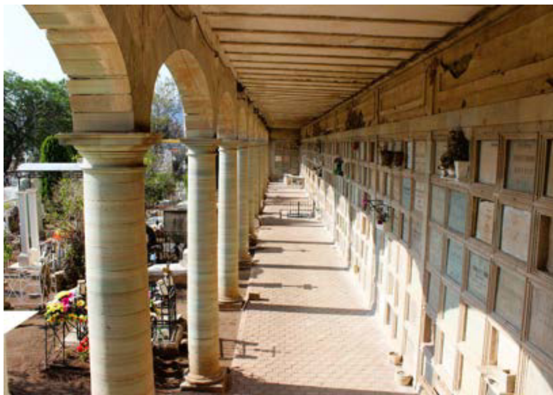
Imagen 8. La zona de arqueadas con 12 columnas. A la derecha el muro de gavetas de finales del siglo XIX. Arriba de éstas, se muestra el entrepañó moldurado en mal estado con pérdida del acabado. 11 de junio de 2024. (Fotografía por Gonzalo Marín).
