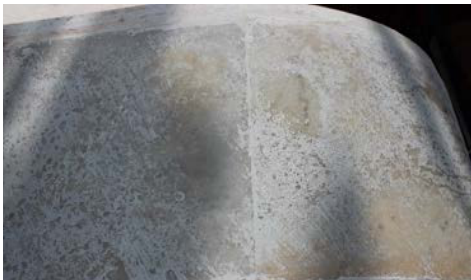
Imagen 33. Pintura a la cal sobre el mármol. Ubicación en el catálogo del Panteón de Santa Paula con la ficha técnica número 22. (Fotografía por Gonzalo Marín).
