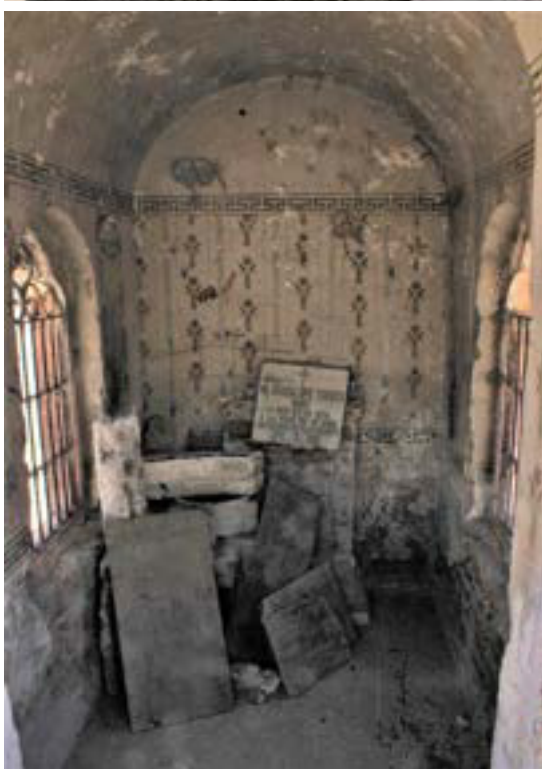
Imagen 74. Cubierta en mortero, invasión de musgo y deslaminación.
