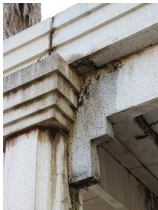
Imagen 149. Costra negra, humedad, filtración de agua.
