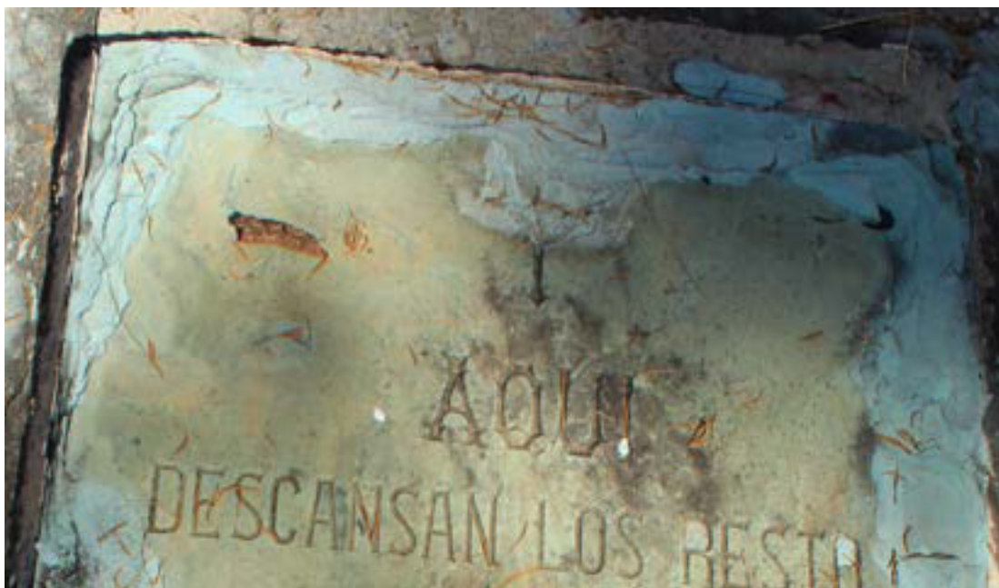
Imagen 36. Deslaminación de la lápida.
