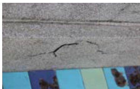
Imágenes 133 y 134. Desconchaduras, lado izquierdo, en la base y el primer dado.
