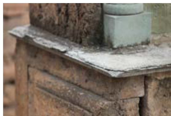
Imagen 106. Musgo y deslaminación de la cantera.
