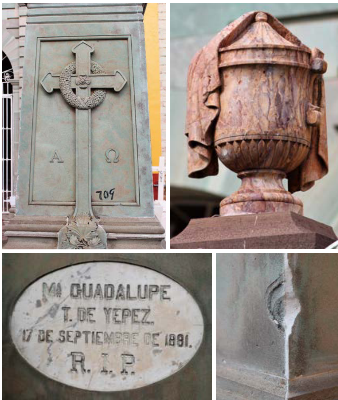
Imagen 44. Vista de la ornamentación del cipo. Imagen 45. Perdida de la agarradera del ánfora. Imagen 46. Fisuras alrededor de la lápida. Imagen 47. Estallido esquina del cipo.
