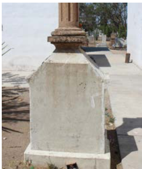
Imagen 53. Vista detrás de la cabecera con fisuras vinculadas.
