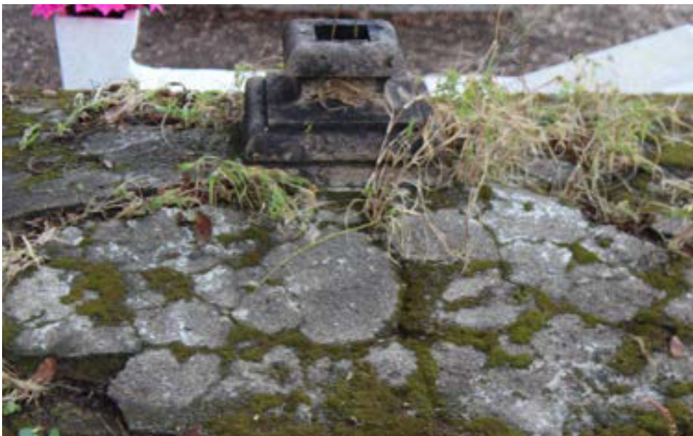
Imagen 50 y 51. Vista de lado de los nichos, descamación y pérdida del recubrimiento. Vista de la cubierta exterior, invasión de musgo y hierbas.
