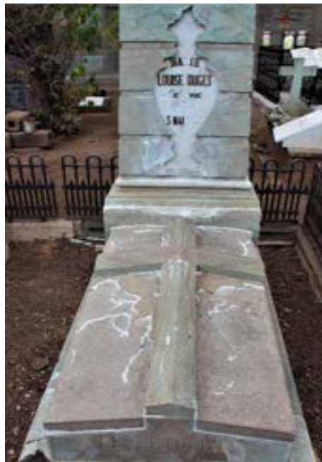
Imagen 56. Fisuras individuales y descamación.
