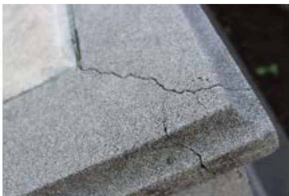
Imagen 109. Fisuras vinculadas.
