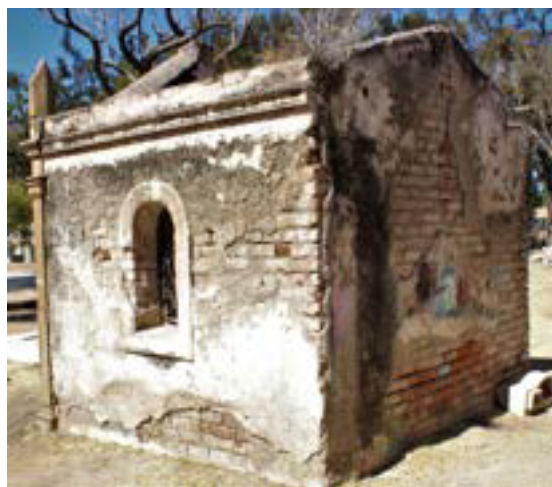
Imágenes 50 y 51. Pérdida del recubrimiento del tabique y hierbas en los muros exteriores.
