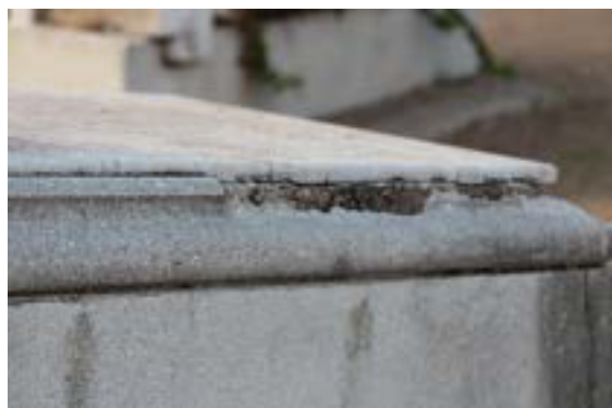
Imágenes 90 y 91. Fisuras individuales en la lápida de mármol. Alrededor de la lápida el granito de la base se ha estado desprendiendo.
