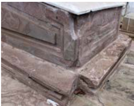
Imágenes 86 y 87. Fragmentación y deslaminación de la cantera, lado izquierdo y lado derecho.
