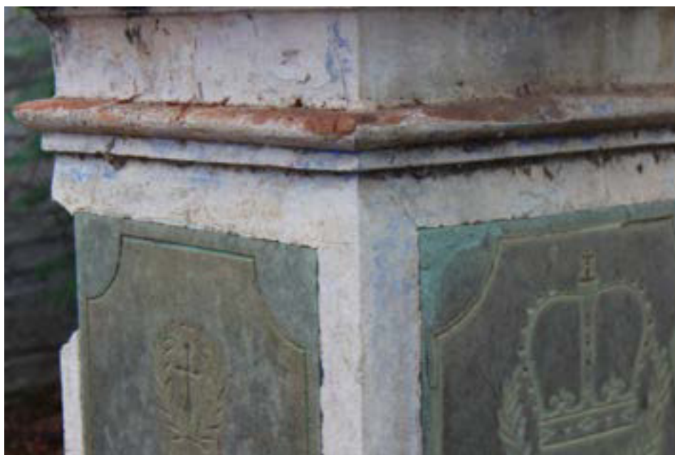
Imagen 28. Fractura en la cornisa e invasión de musgo en la base de la cruz.
