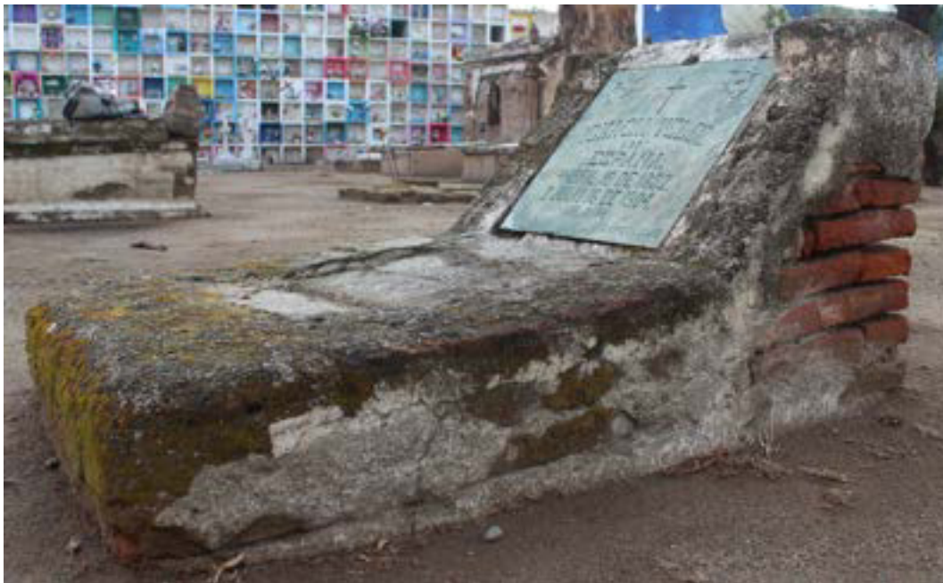
Imagen 21. Invasión de musgo y pérdida del recubrimiento de la escrutara.
