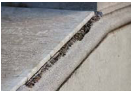
Imágenes 90 y 91. Fisuras individuales en la lápida de mármol. Alrededor de la lápida el granito de la base se ha estado desprendiendo.
