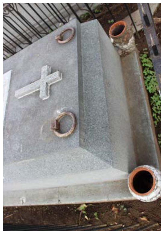
Imagen 97 y 98. Aldabas de hierro con invasión de oxido. Tiene un faltante, el jarrón en la parte frontal de la tumba.
