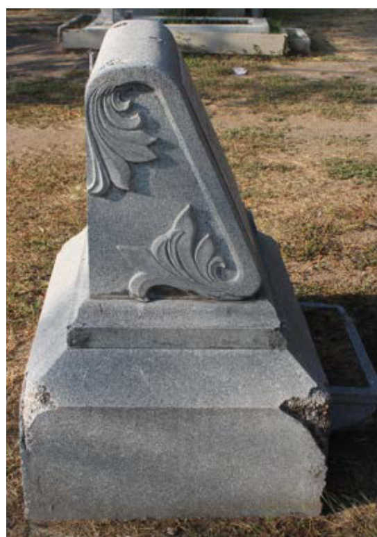
Imágenes 113, 114 y 115. Fracturas en la parte superior y fragmentaciones en esquinas de la base del cipo.
