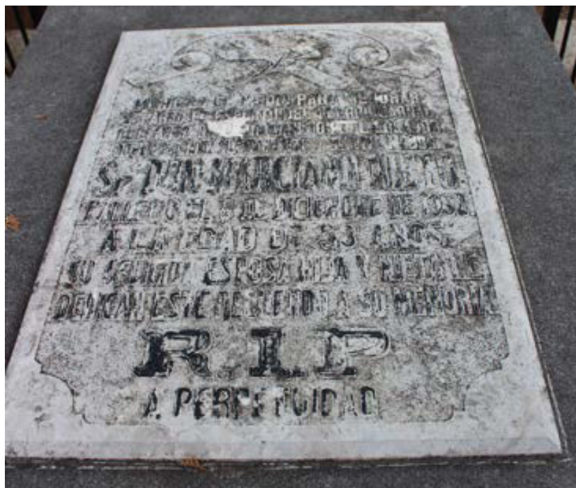
Imagen 96. Perdida de la tinta negra de las letras. Invasión de pitting.
