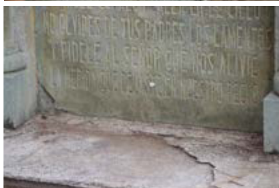
Imágenes 107, 108, 109 y 110. Desprendimiento y fragmentación de la cruz. Descamación de la base del nicho. Coloración, costra marrón y fisura individual.
