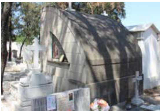
Imagen 176. Costra negra en la cubierta.
