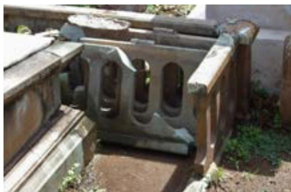
Imágenes 134. Los lados del vallado en cantera verde fragmentado.
