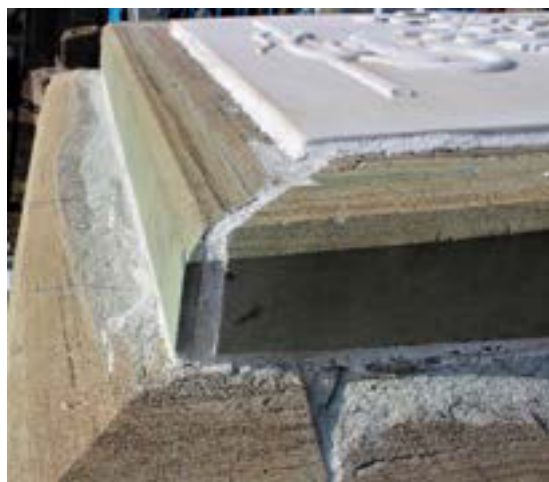
Imagen 78. Emboquillado de las juntas de los bloques de piedra.
