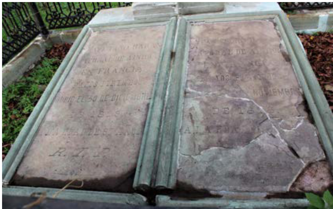
Imagen 41. Vista de las lápidas en cantera, fracturas transversales, descamación y pérdida de elemento en la esquina inferior derecha.
