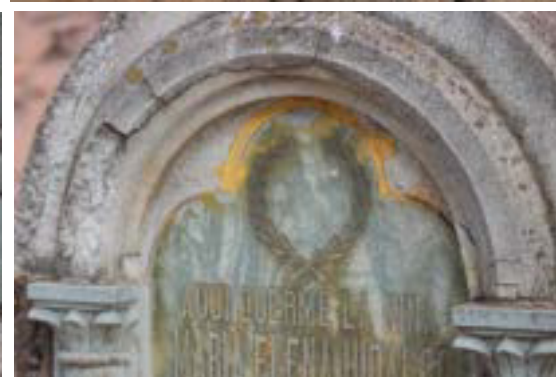
Imágenes 107, 108, 109 y 110. Desprendimiento y fragmentación de la cruz. Descamación de la base del nicho. Coloración, costra marrón y fisura individual.
