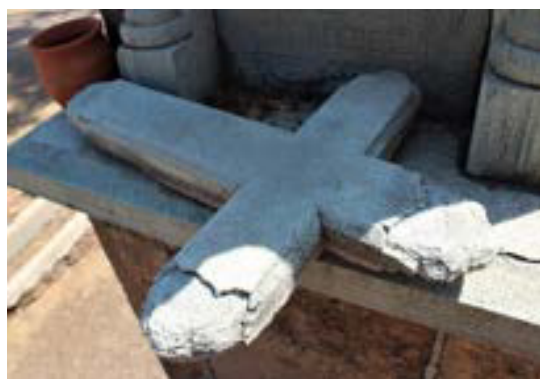
Imagen 119. Cruz desprendida y con descamación.
