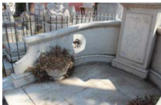
Imagen 137. Eflorescencia en la parte baja de monumento.
