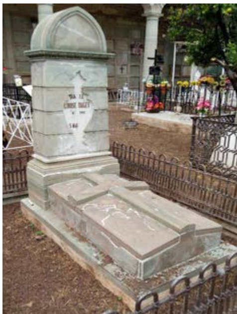
Imagen 57. Faltante de letras, tinción y deslaminación.
