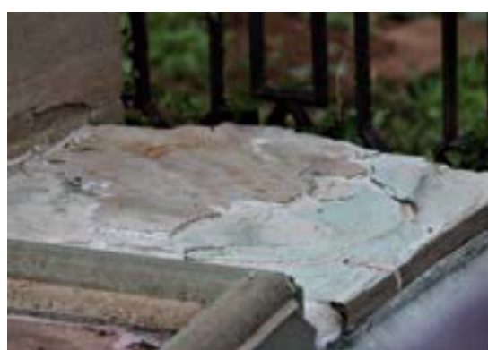
Imágenes 42 y 43. La descamación y pérdida de datos.
