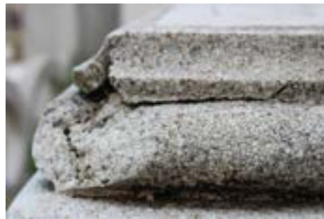
Imagen 126. Fragmentación en la esquina lado izquierdo de la lápida.
