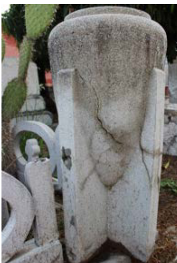
Imagen 123. Fisuras vinculadas en el jarrón y desprendimiento de la valla.
