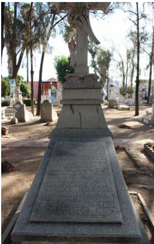
Imagen 138. Fisuras en la cabecera y enmugrecimiento de la lápida.
