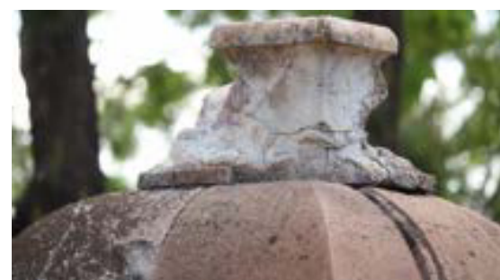
Imagen 42. Deterioro de la base en cantera.
