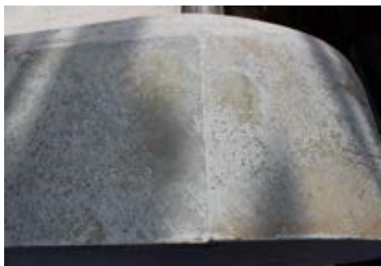
Imágenes 128 y 129. Tinción y enmugrecimiento en el mármol debajo de la pintura blanca.
