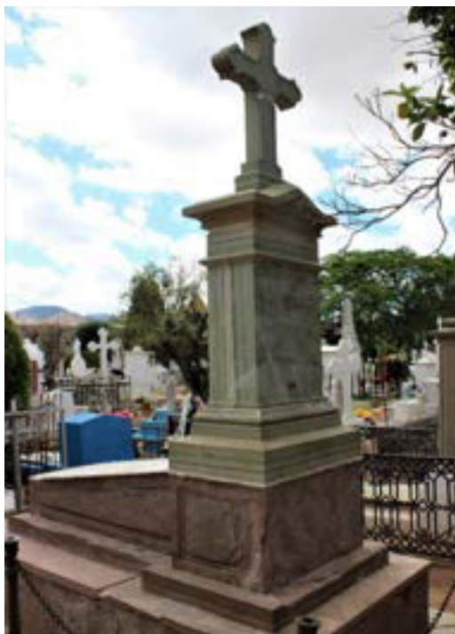
Imagen 84. Vista detrás de la tumba. Descamación en la base en cantera café. Fisuras individuales en el cipo.
