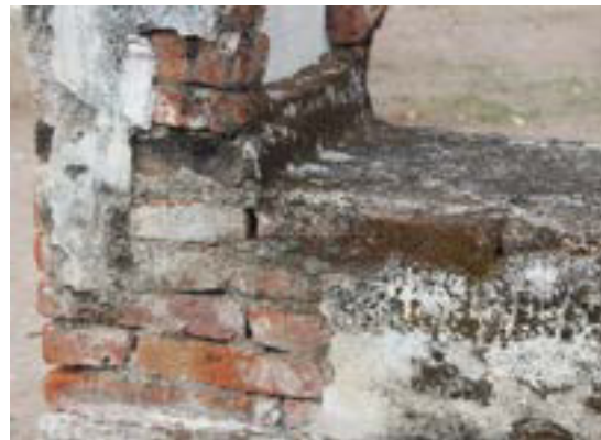
Imagen 66. Perdida del recubrimiento.
