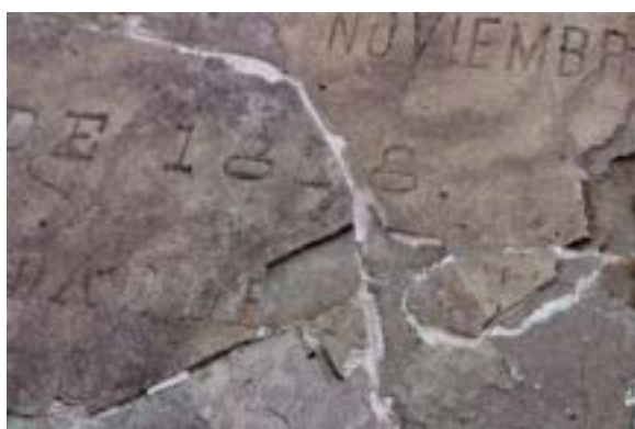
Imágenes 42 y 43. La descamación y pérdida de datos.
