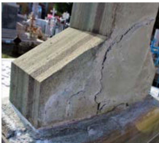
Imagen 79. Deslaminación en la parte baja de la cruz.
