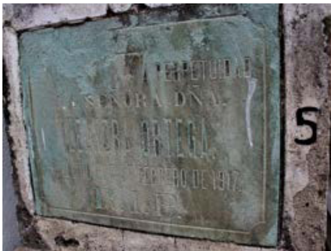
Imagen 55. Descamación de la cantera de la lápida.
