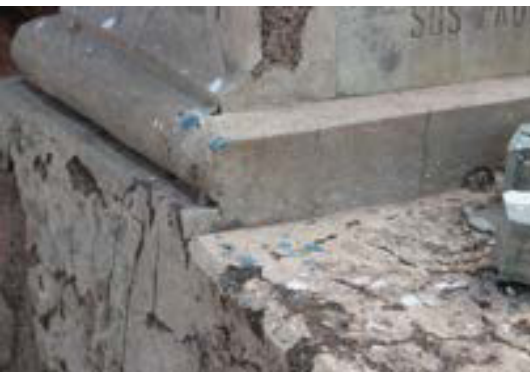
Imagen 80. salpicaduras de pintura azul y fracturas individuales.
