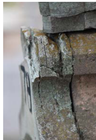
Imagen 106. Musgo y deslaminación de la cantera.
