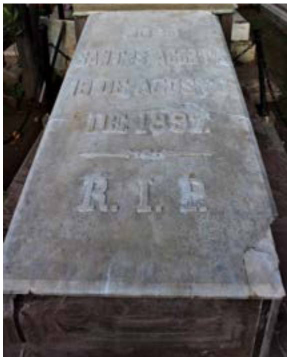
Imagen 85. Fisura transversal y fisuras individuales. Fragmentación en la esquina derecha. La lápida fue pintada de blanco.
