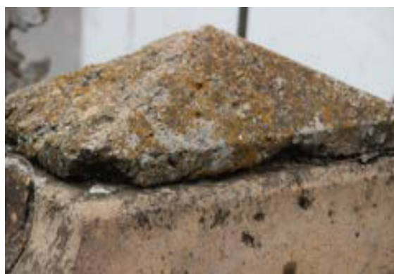
Imagen 46. Invasión de musgo y liquen, además de alveolización y fracturas.
