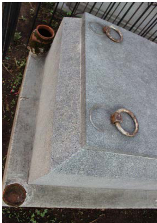
Imagen 97 y 98. Aldabas de hierro con invasión de oxido. Tiene un faltante, el jarrón en la parte frontal de la tumba.
