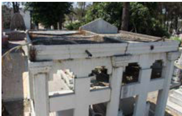
Imágenes 145 y 146. Hierba y elemento desprendido en el techo.
