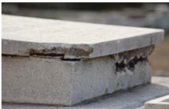
Imagen 87. Perdida de la esquina de la lápida y fractura horizontal en la base.
