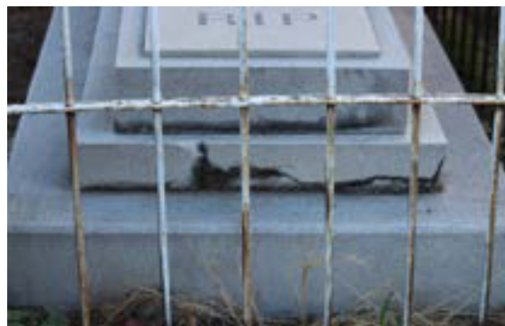
Imagen 165. Fracturas y desconchadura.
