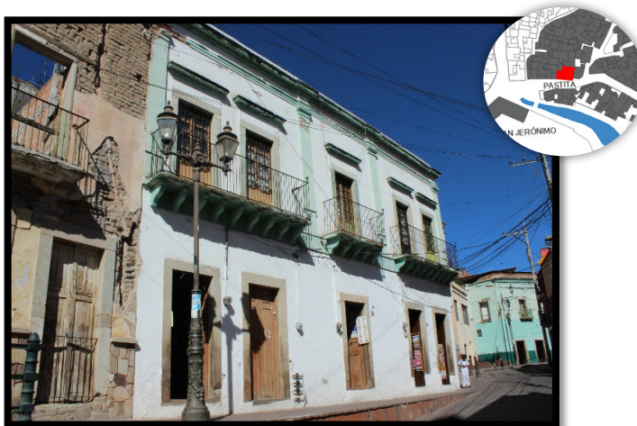
Ilustración 18 Fachada de estilo Neoclásico al oeste de la calle Pastita. En el segundo nivel los balcones y pilastras decorativas con capiteles de orden dórico, tres platabandas y friso liso; vanos enmarcados con cantería. (fotografía de autoría propia, 2016)
