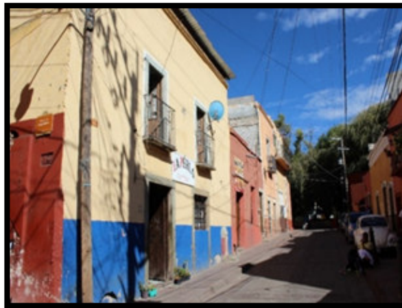
Ilustración 43. Fachada principal del inmueble ubicado en la calle Pastita n°52, 54 y 56, vista de la esquina con el callejón los Imposibles. (fotografía de autoría propia, 2016)
