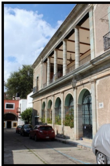
Ilustración 66 Fachada sureste del edificio ubicado en la calle San Bernabé n° 1. (fotografía de autoría propia, 2016)
