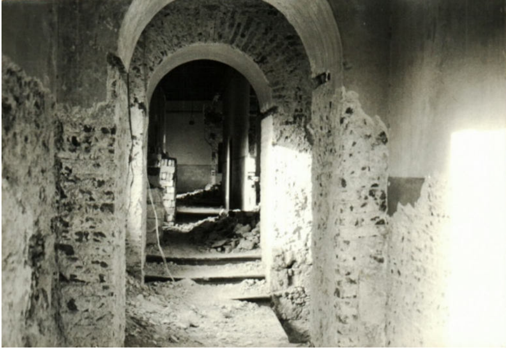
Imagen 51. Trabajos en el interior.
