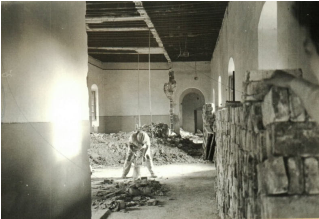
Imagen 50. Trabajos en el interior.
