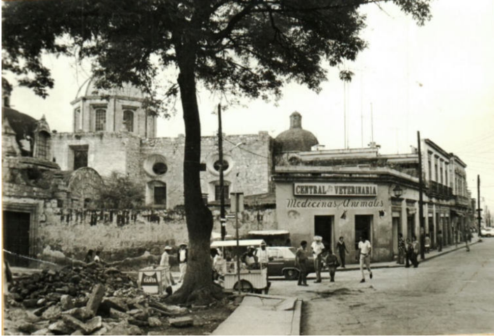
Imagen 41. Exterior sobre la calle Morelos y construcciones Adyacentes.
