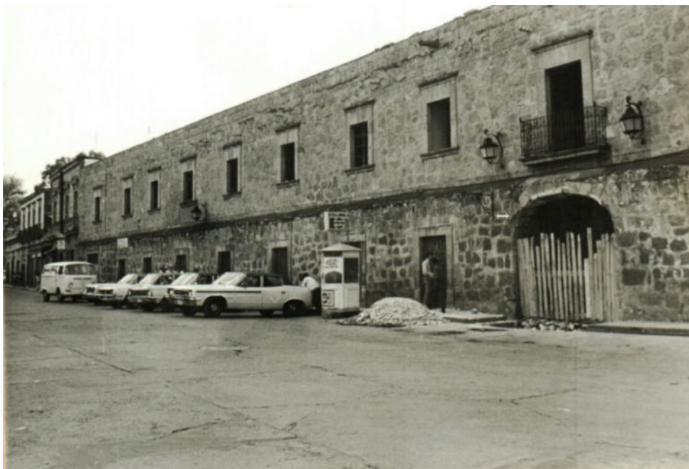
Imagen 40. Exterior sobre la calle Morelos y construcciones adyacentes.
